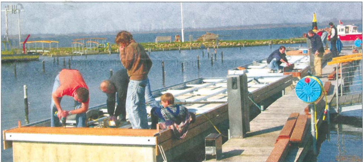
Fleißige Helfer der Seglervereinigung Hude haben die Schwimmstege vor dem neuen Hafen eingesetzt.
